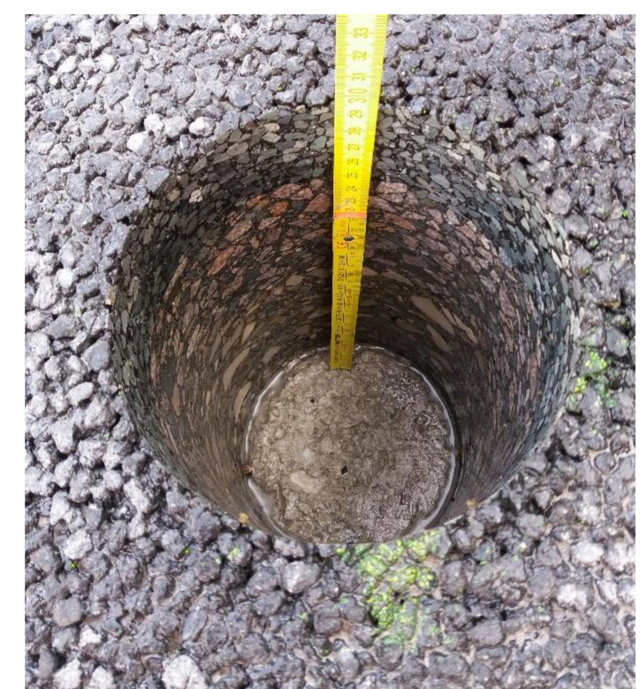
Bohrloch nach Bohrkernentnahme (Materialeigenschaften)
