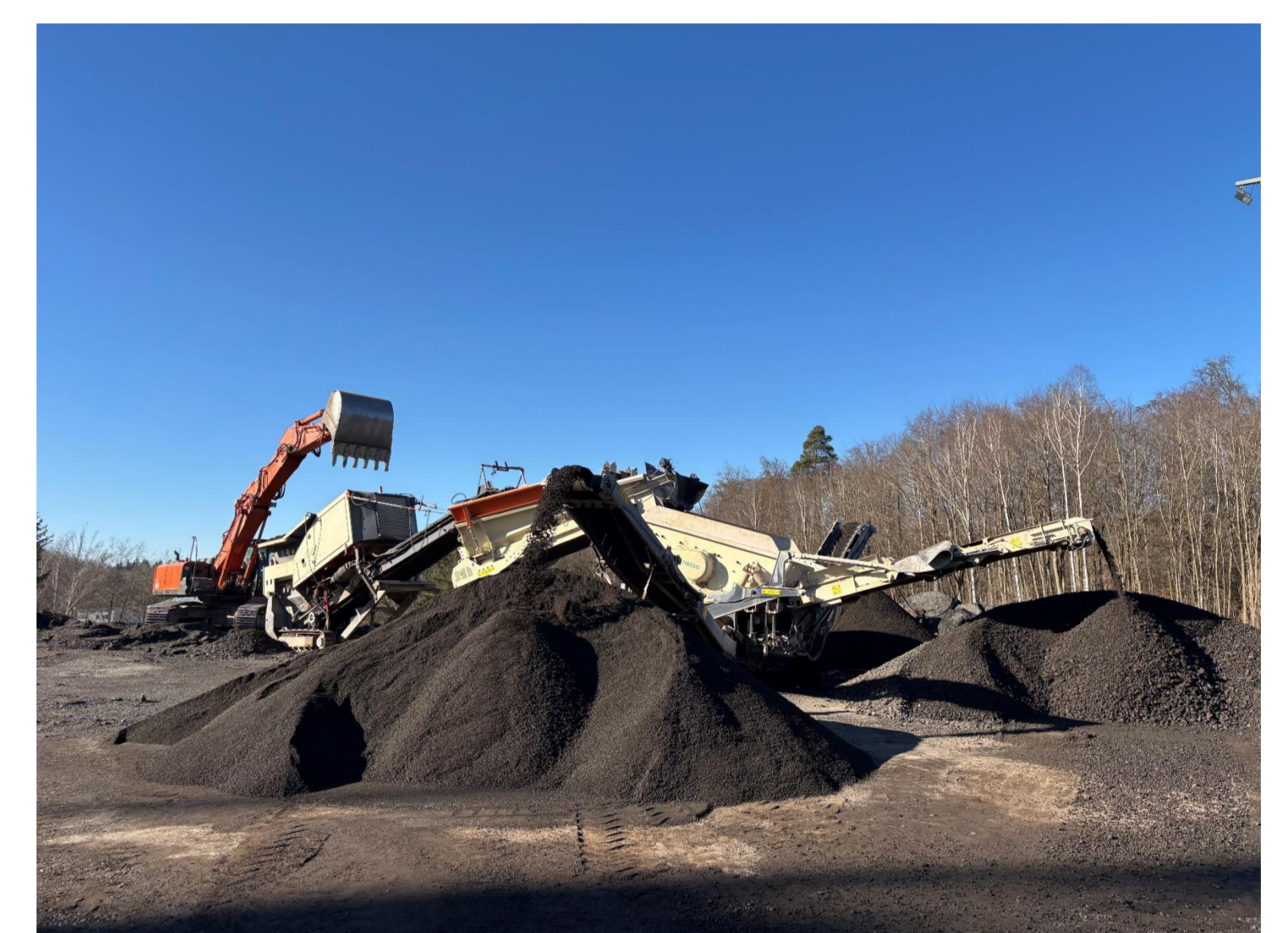
Aufbereitung von Ausbausasphalt
