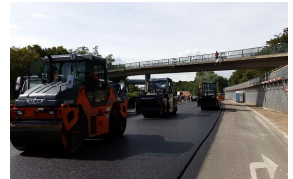
Einbau einer lärmindernden Asphaltdeckschicht
